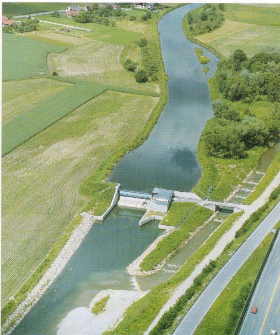
Das Kraftwerk Mürzhofen mit integriertem Auwald
