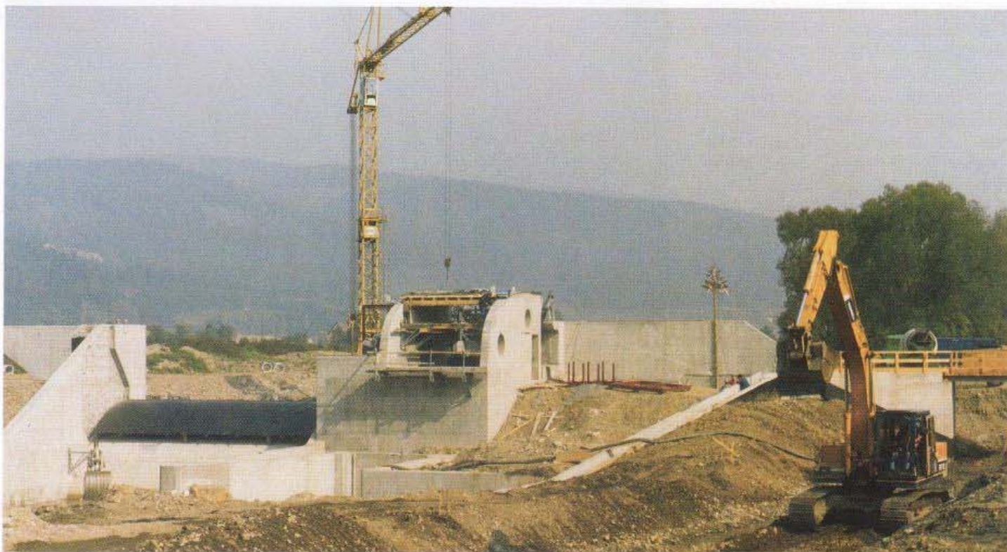
Gesamtansicht der Baustelle mit Wehr, Krafthaus, Fischaufstieg und Überbrückung des neuen Stanzbachgerinnes
